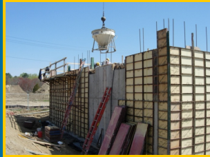
Wall Pour In Progress
