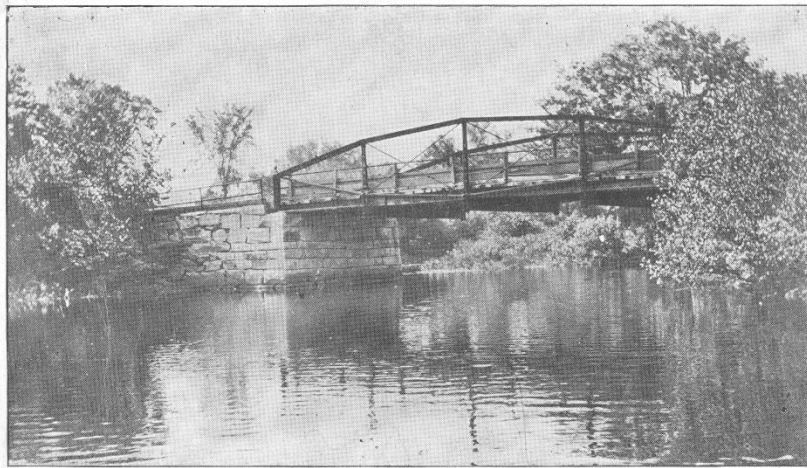
WADLEY'S BRIDGE, LEE, N. H.
